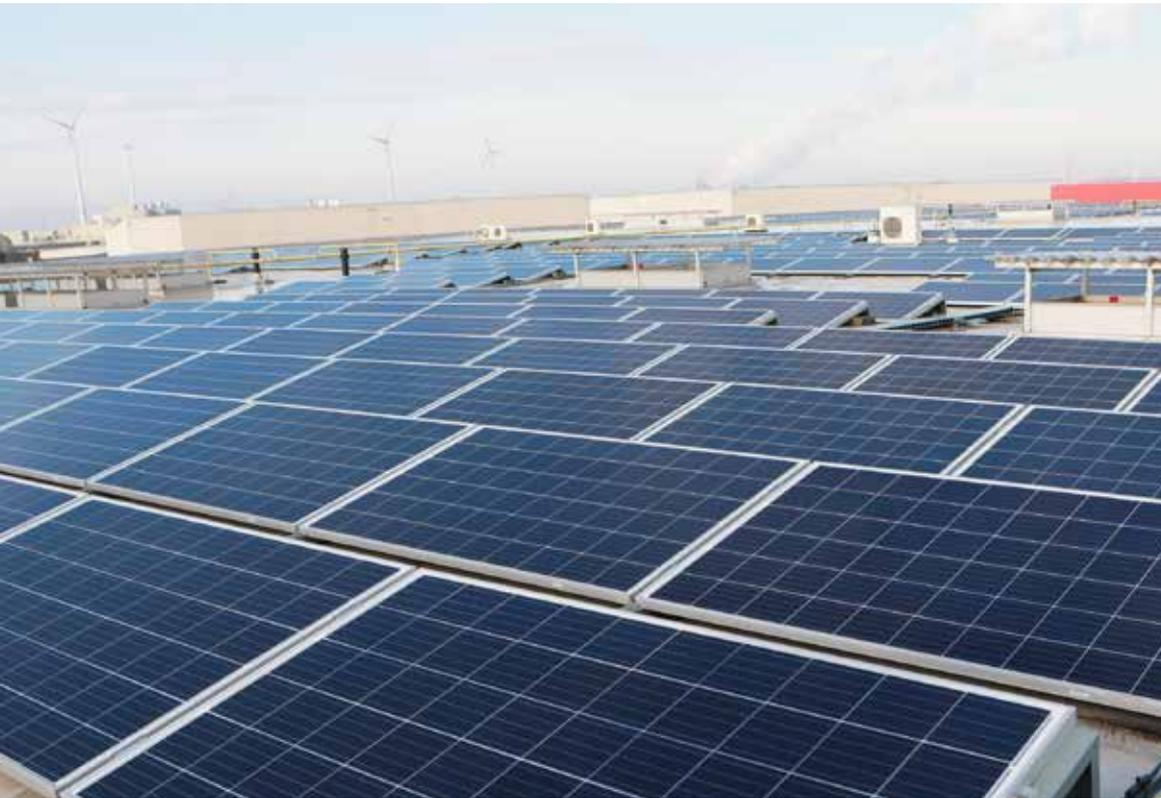
Les toits du centre de tri de bpost à Anvers recouverts de 8.000 m<sup>2</sup> de panneaux solaires
